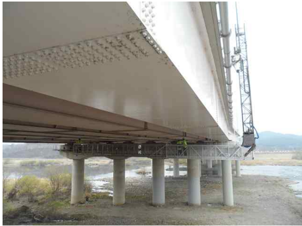
교량점검차를 이용한 근접조사
